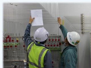
現場での据付工事・各種検査
