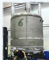
大型タンク製作
